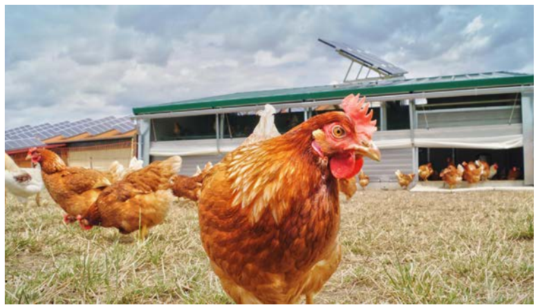
Bild 1: Legehennenstall mit Photovoltaik (Quelle: Wördekemper GmbH & Co. KG)
