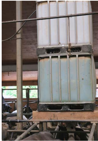
Bild 4: Das erwärmte Wasser aus dem Vorkühler wird neben dem Melkstand in zwei Tanks aufgefangen und so den Kühen unmittelbar nach dem Melken in einer Tränke bereitgestellt.
