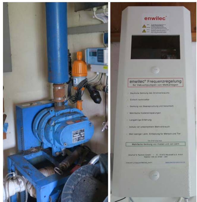
■ Bild 1: Nachrüsten der bestehenden Vakuumpumpe auf Frequenzsteuerung (alle Fotos: Eva Nowatschin).
